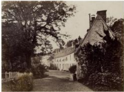
Vue de la maison des propriétaires de l'usine du Marais, à Jouy-sur-Morin. ©LOUIS-EMILE DURANDELLE
