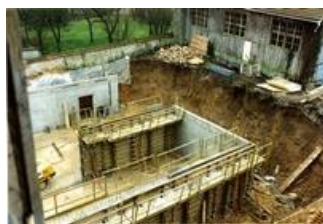
Le chantier du musée des Pays de Seine-et-Marne en 1994 Cliché Evelyne Baron/MDSM
